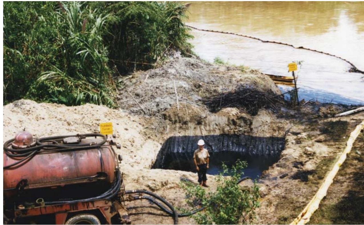
Trabajos de restauración ambiental en el caño La Linda y el río Sardinata, luego de un atentado.
