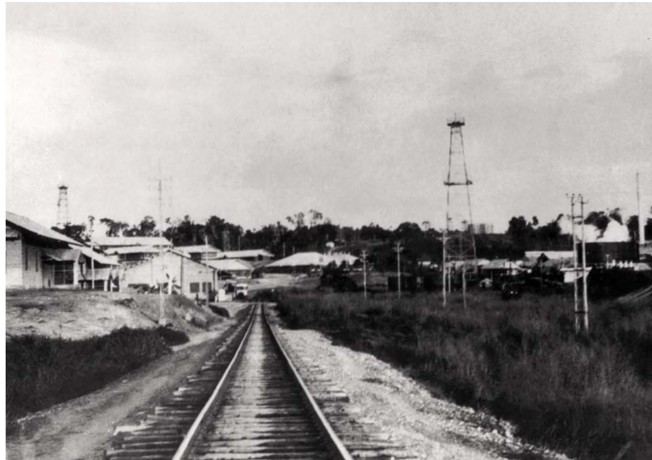
Dos aspectos de la construcción del ferrocarril que la Tropical Oil Company tendió de Barrancabermeja a sus instalaciones en El Centro, entre 1922 y 1927.
