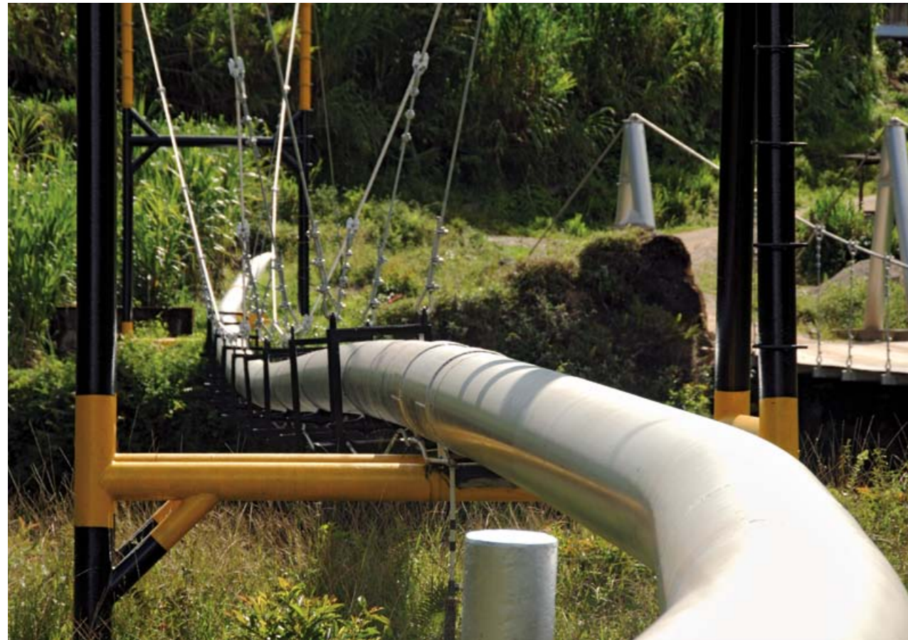
Páginas 200-201: Construcción del gasoducto La Guajira- Venezuela, a finales de la década de 1990.
