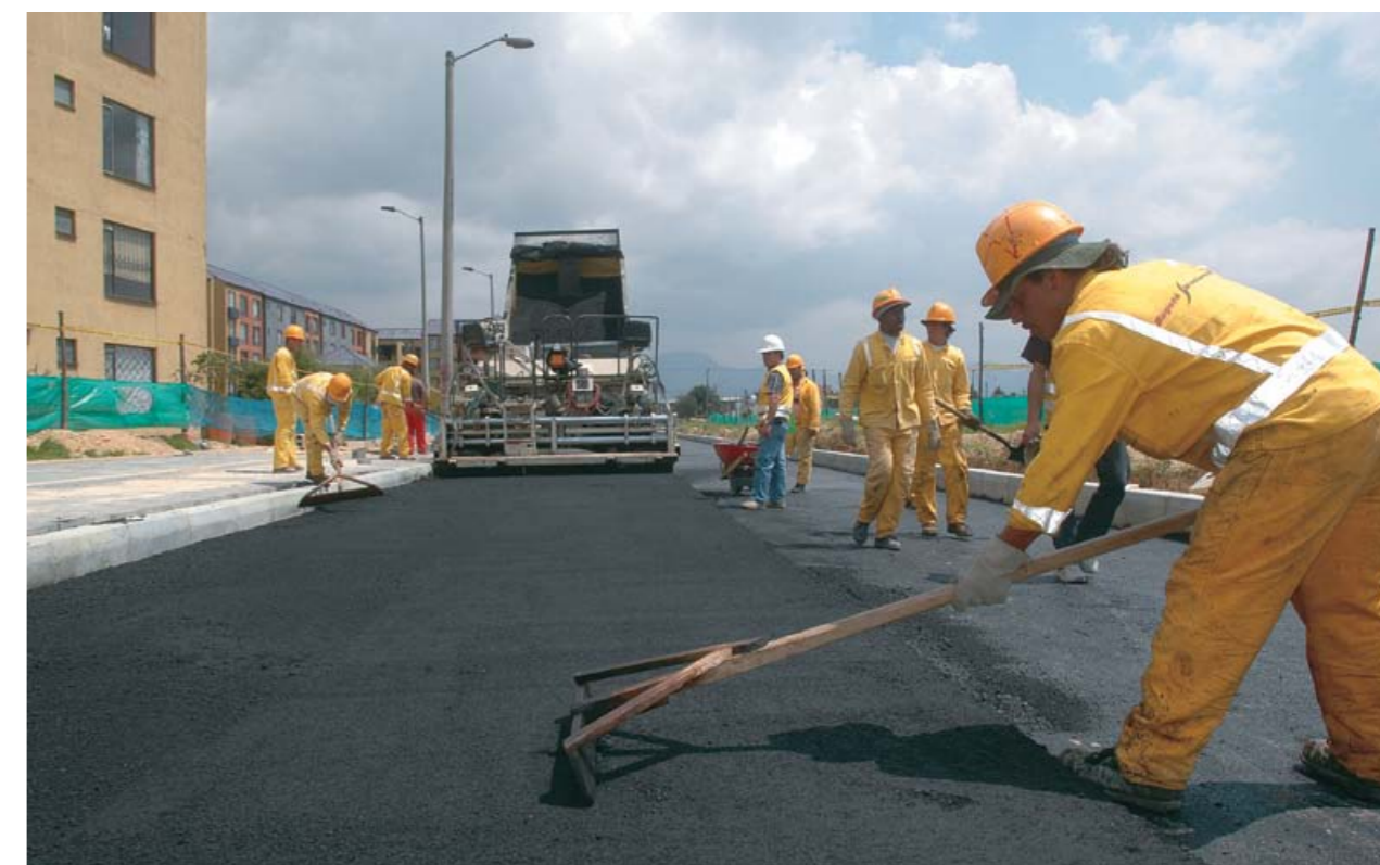
Programa de pavimentación en las proximidades de la refinería en Barrancabermeja.
