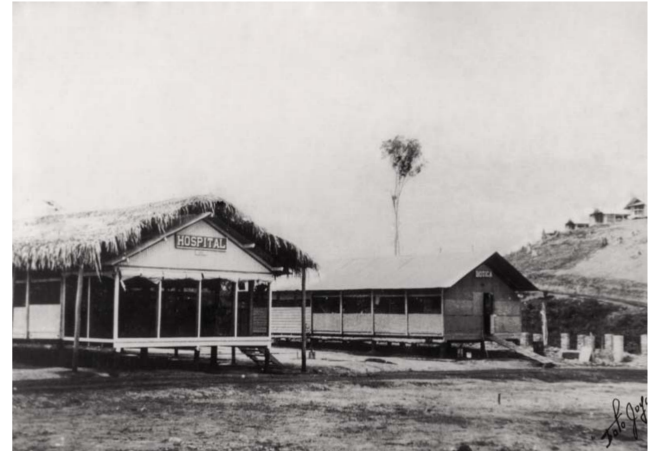
Primer hospital y botica de la Tropical Oil Company. Abajo: torre de explotación petrolera y otras instalaciones de la misma compañía en terrenos de la Concesión de Mares, en El Centro, a mediados de la década de 1920.
