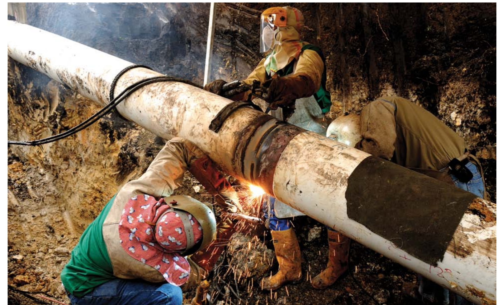
Soldadores en la construcción del Oleoducto de Colombia, ODC.
