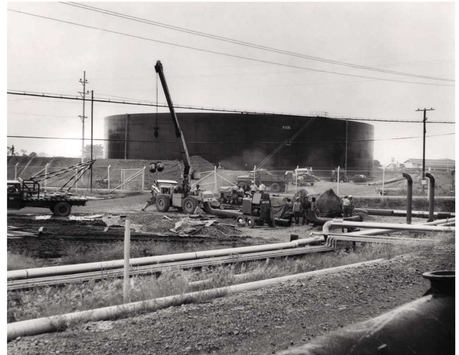
Montaje de bombas y tubería del sistema fuel oil en el puerto de Galán.
