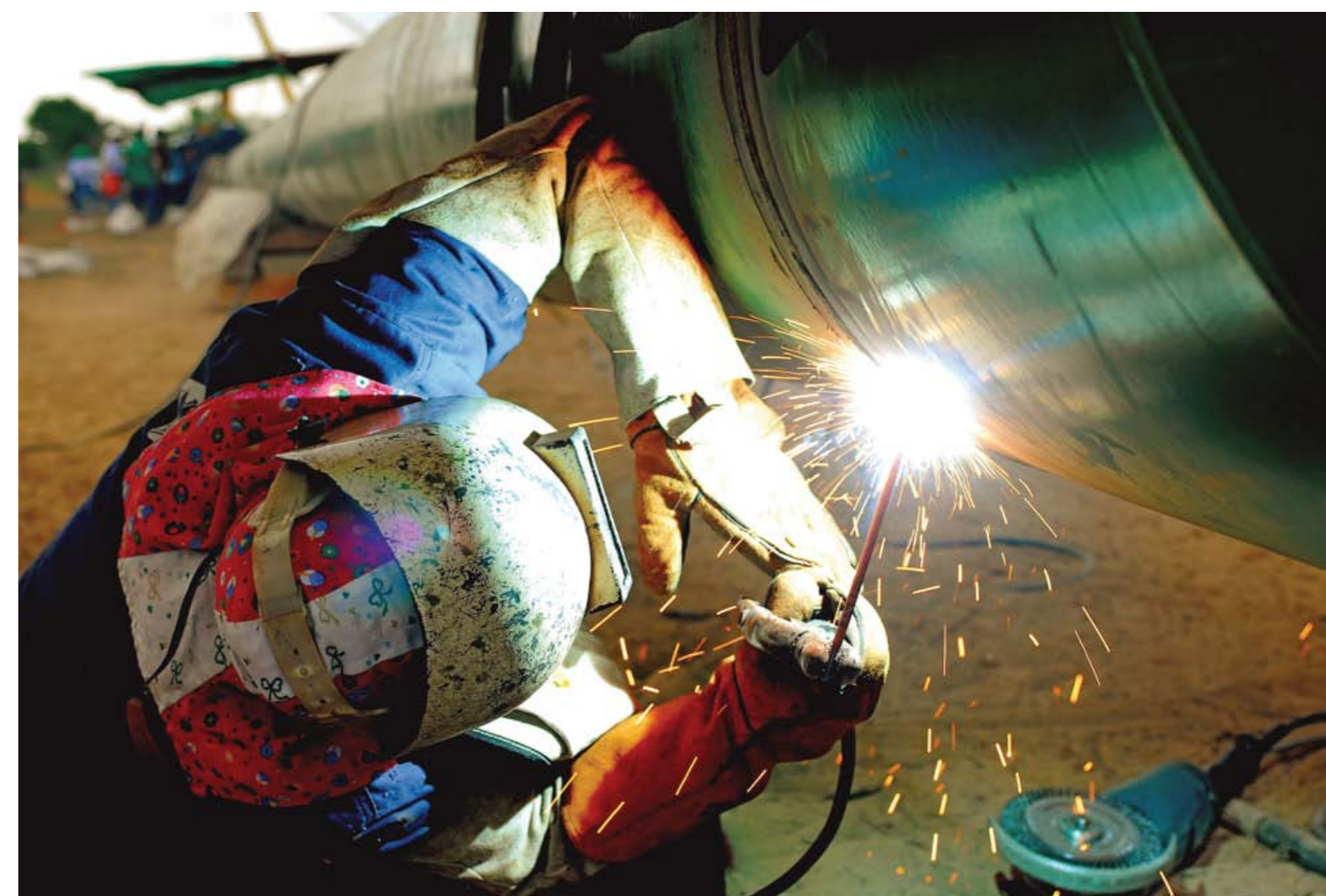
Labores de soldadura en el Oleoducto de Colombia ODC.
