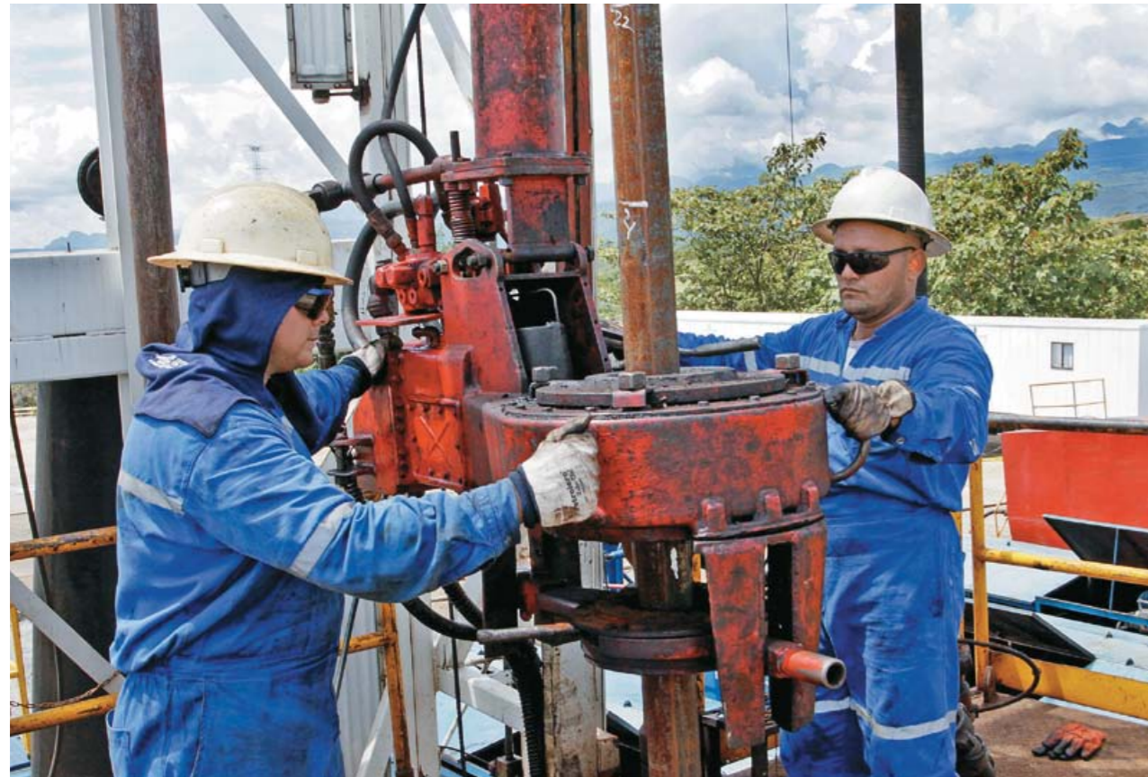
Los instaladores de cuñas ayudan a ubicar la tubería sobre el piso de perforación.
