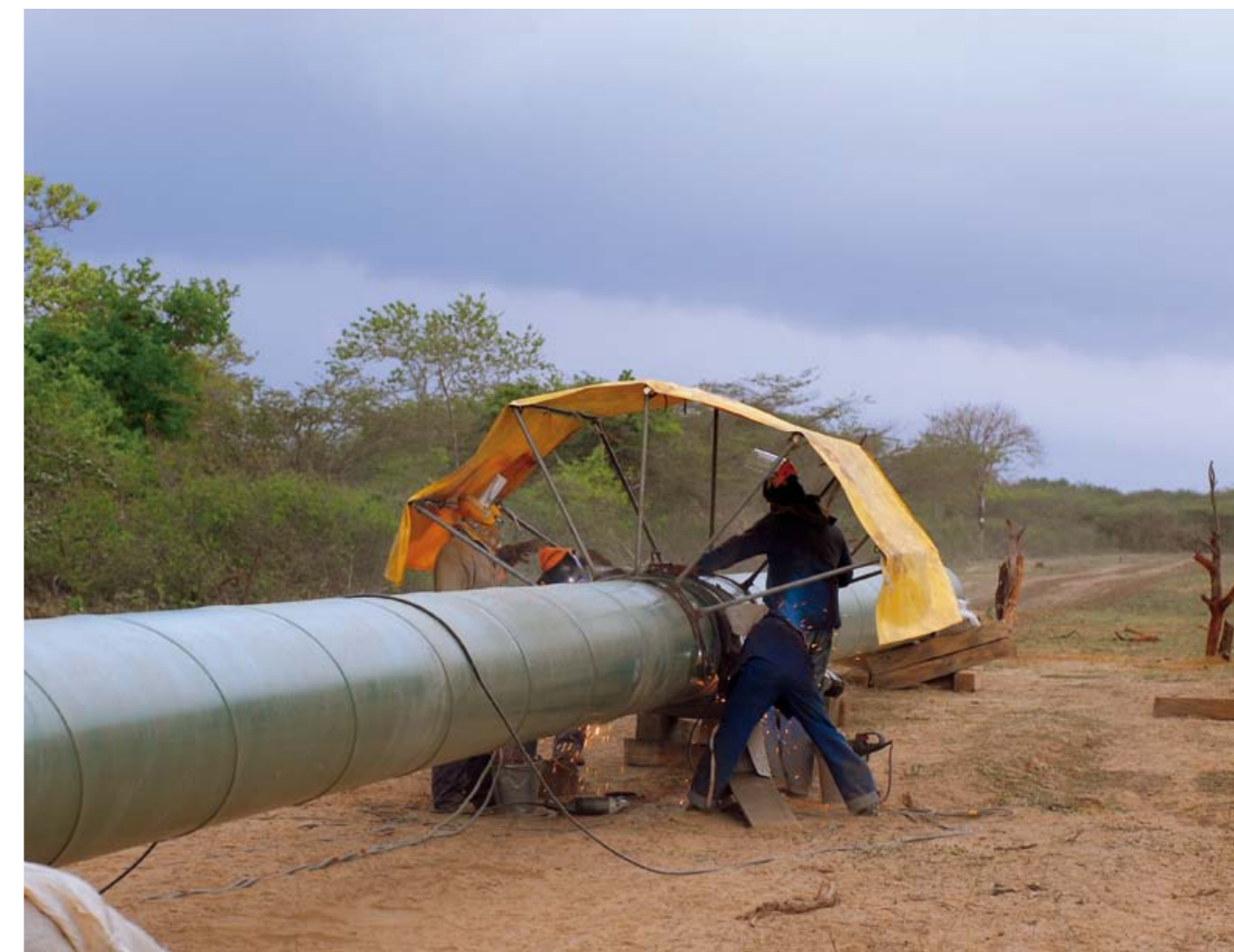
Construcción del gasoducto La Guajira- Venezuela, a finales de la década de 1990.
